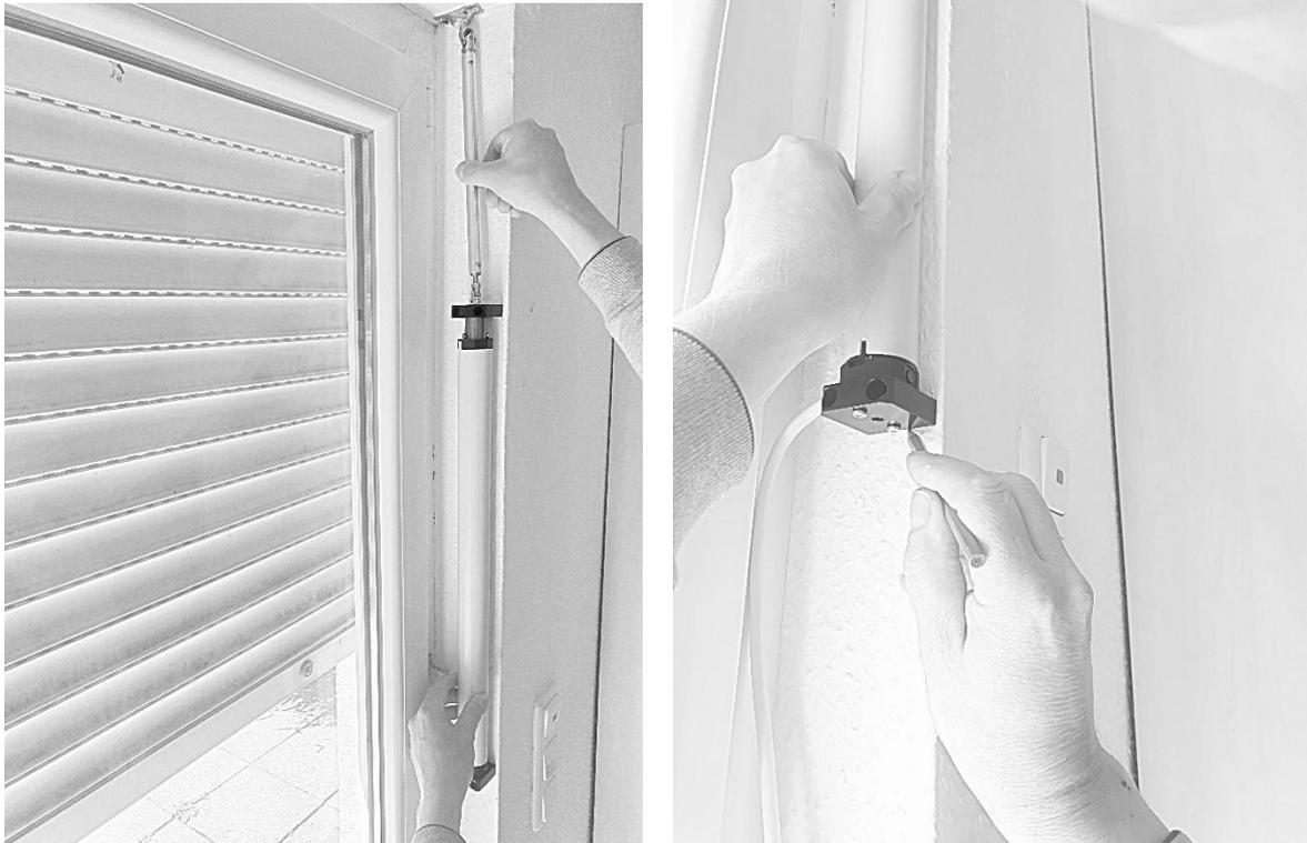
5. Schrauben Sie die M3 Mutter ab, ziehen Sie die M3x16 Schraube heraus und nehmen Sie die Antriebswelle zusammen mit Motor von der Kupplung ab.
